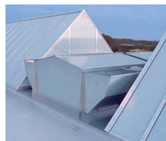
Wywietrznik wielkopowierzchniowy firmy ESSMANN w dwuspadowym paśmie świetlnym
